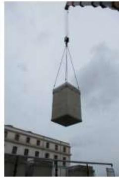
Nous avons besoin de 16m de hauteur pour la manipulation des cuves béton.
